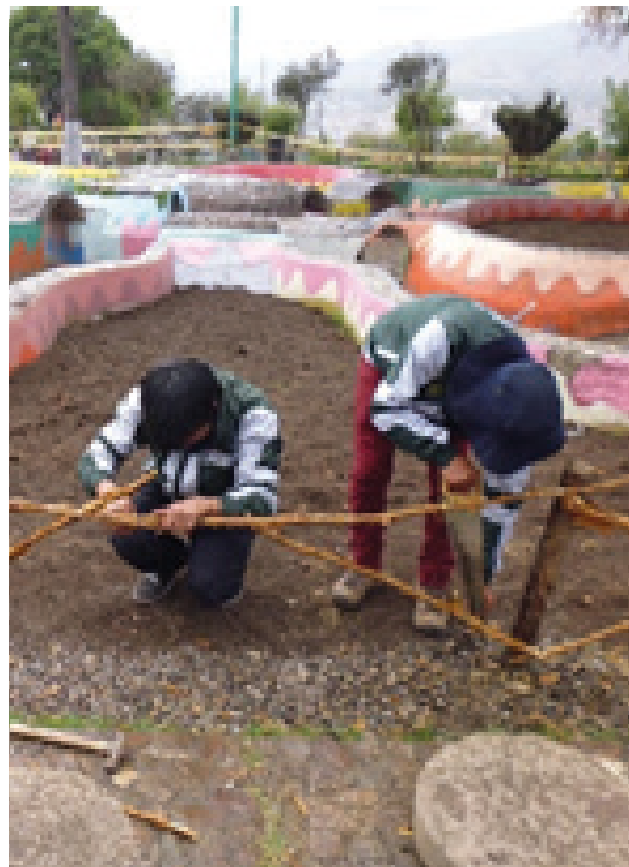
Figura 3. Instalación del cerco de madera.
