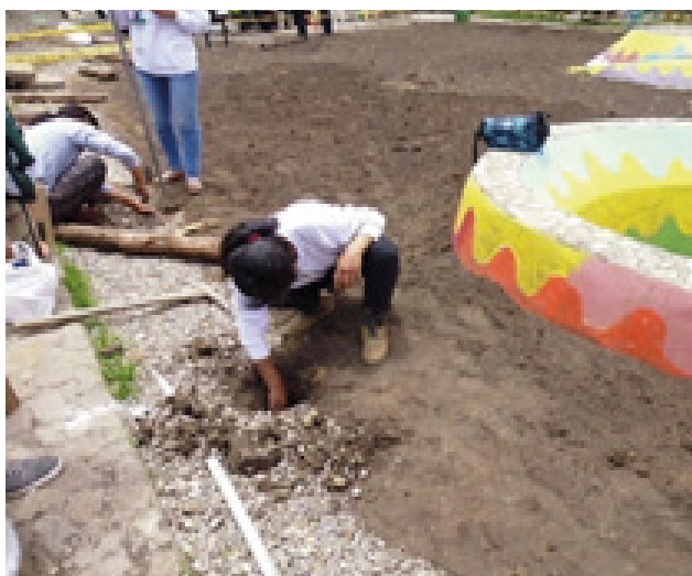
Figura 2. Apertura de hoyos alrededor del área de trabajo.
