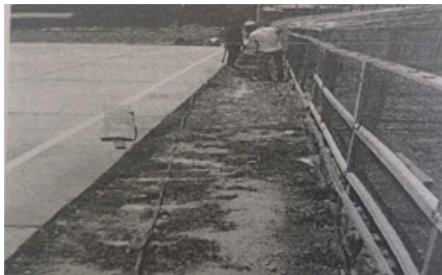
Figura 2. Marcación de hoyos para la instalación de los cercos con casia.
